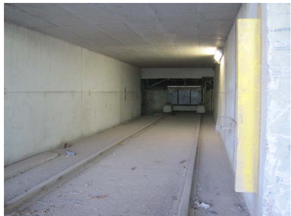
Figura 8. Cunicolo di trasferimento del carrello. Occorre segnalare che questa soluzione di raccolta rende agevole la raccolta e la movimentazione, riducendo la probabilità di dispersioni ed emissioni diffuse che possono derivare da queste operazioni.
